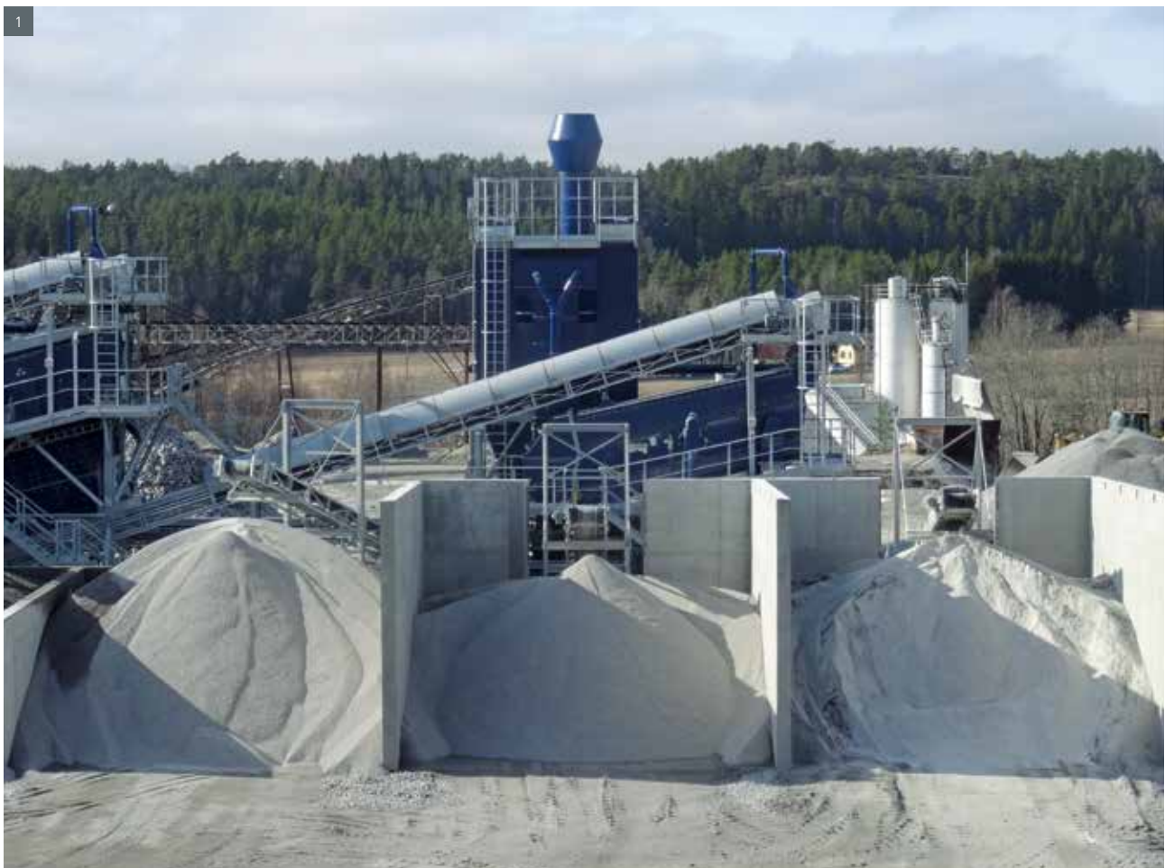
1. Brech- und Siebanlage für Hartgestein / Crushing and screening plant for hard rock
