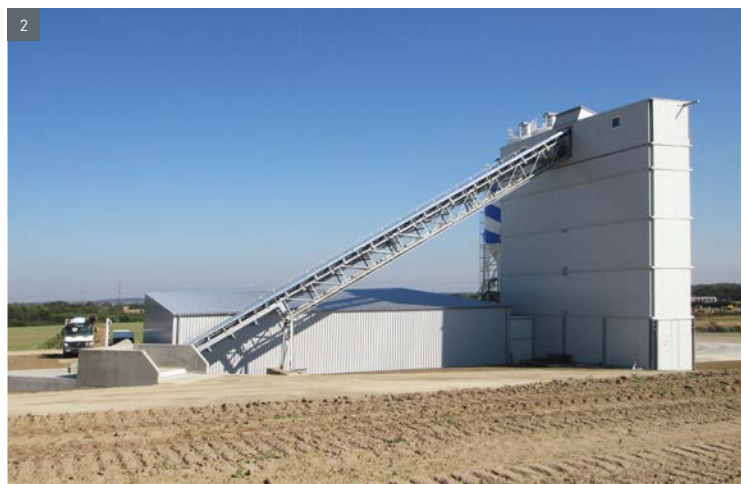
1. Beschickung Hochbunker mittels Gurtbecherwerk / Feeding of container hopper by bucket elevator ■ 2. Beschickung Hochbunker mittels Förderband / Feeding of container hopper by belt conveyor
